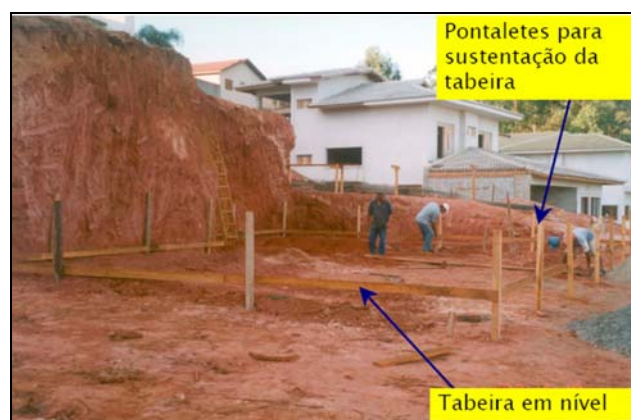
Figura 14.1a - Implantação de um gabarito.
