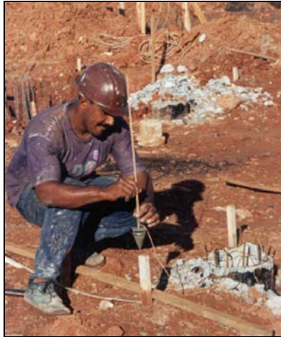
Figura 14.5b – Transferência do ponto para o terreno.
